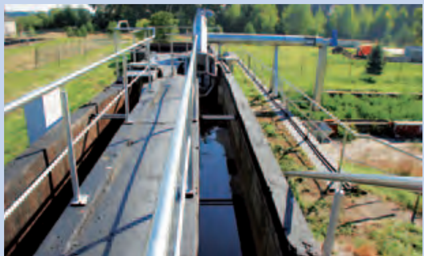
Auf der alten Kläranlage wird der Rechen ausgetauscht.
